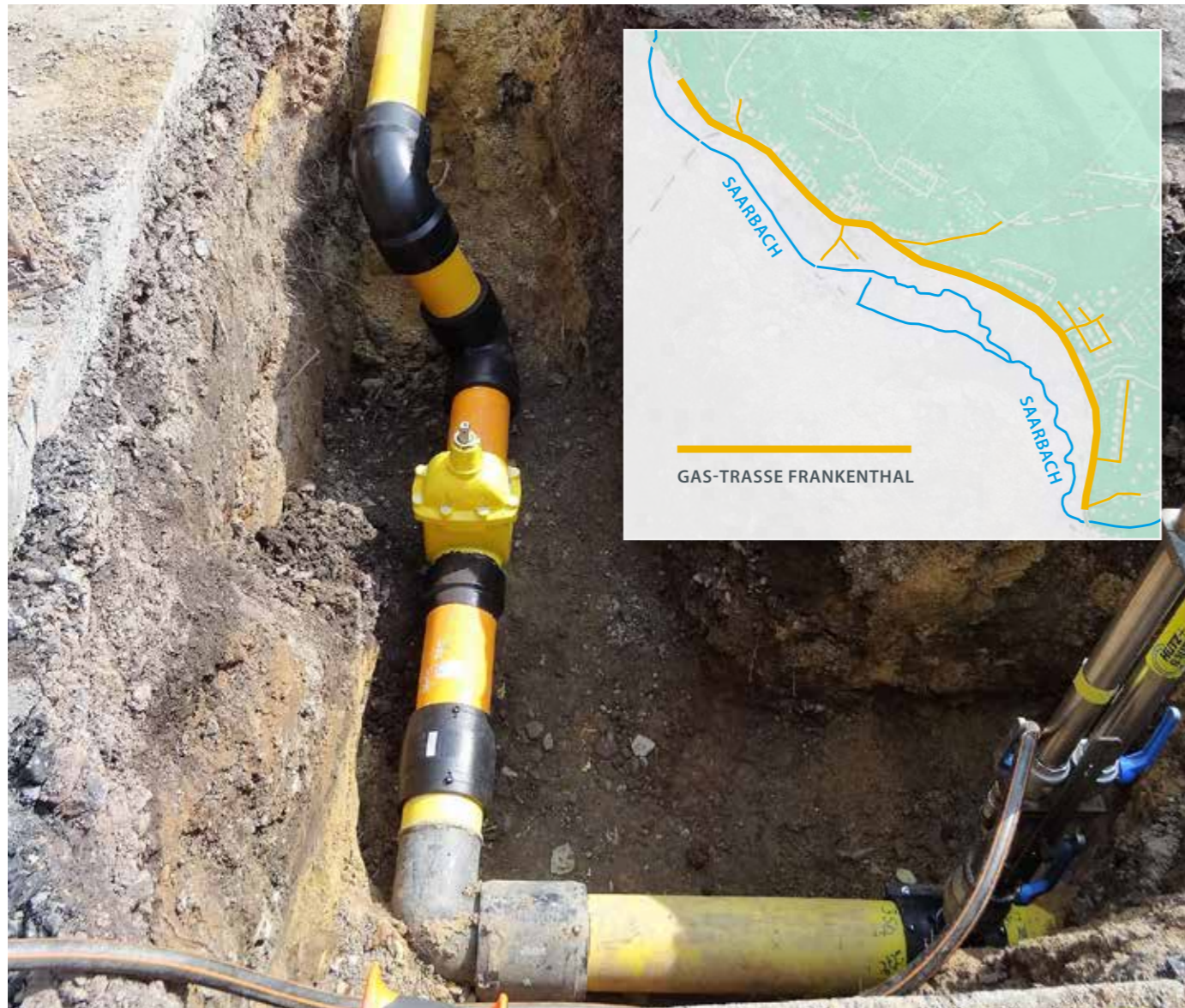
AB MITTE 2021 WERDEN RUND 2500 METER GASLEITUNGEN DURCH FRANKENTHAL GELEGT.
