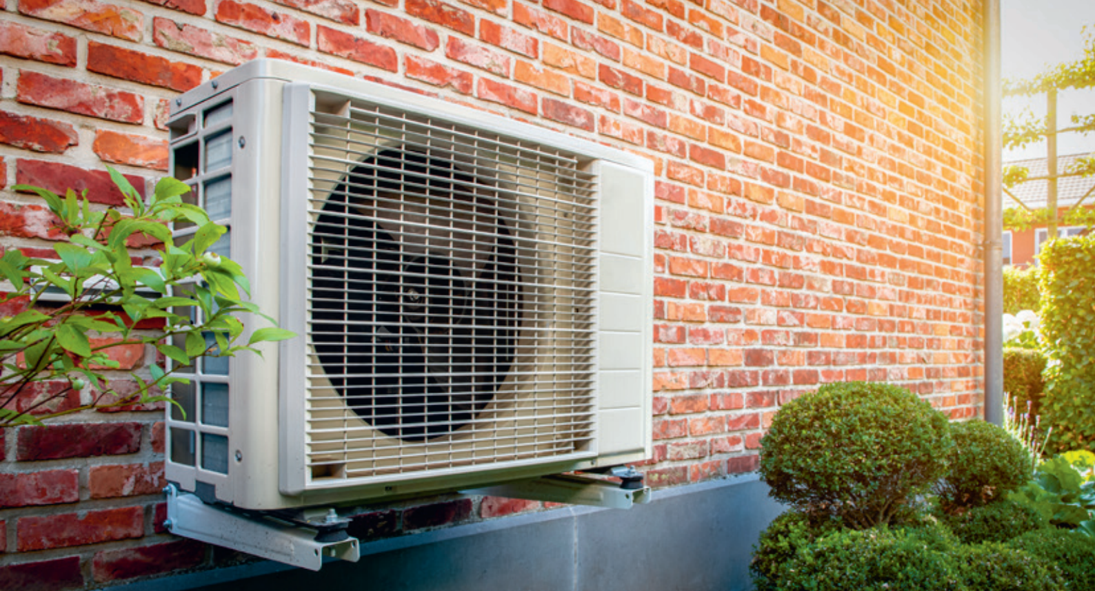
Eine Luft-Wärmepumpe dient zum Kühlen oder Heizen eines Hauses.
