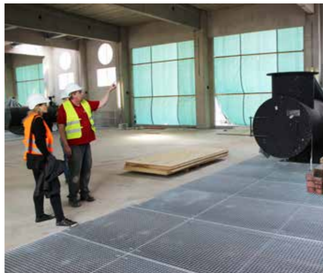
BAULEITER MARIO TRAXEL (RE.) ZEIGT TINA SCHREITER VON DER EGG WO KÜNFTIG DIE LÜFTUNGSANLAGEN INSTALLIERT WERDEN
