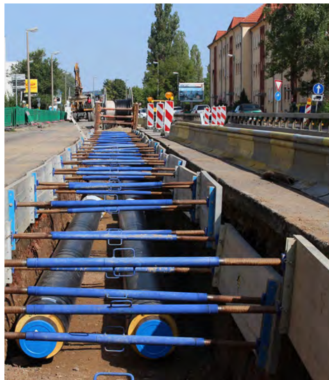
DIE BAUARBEITEN AN DER FERNWÄRMETRASSE GEHEN VORAN. DIE NEUERLEGUNG VON FERNWÄRMEROHREN IN DER THEATERSTRASSE IST BEREITS ABGESCHLOSSEN
