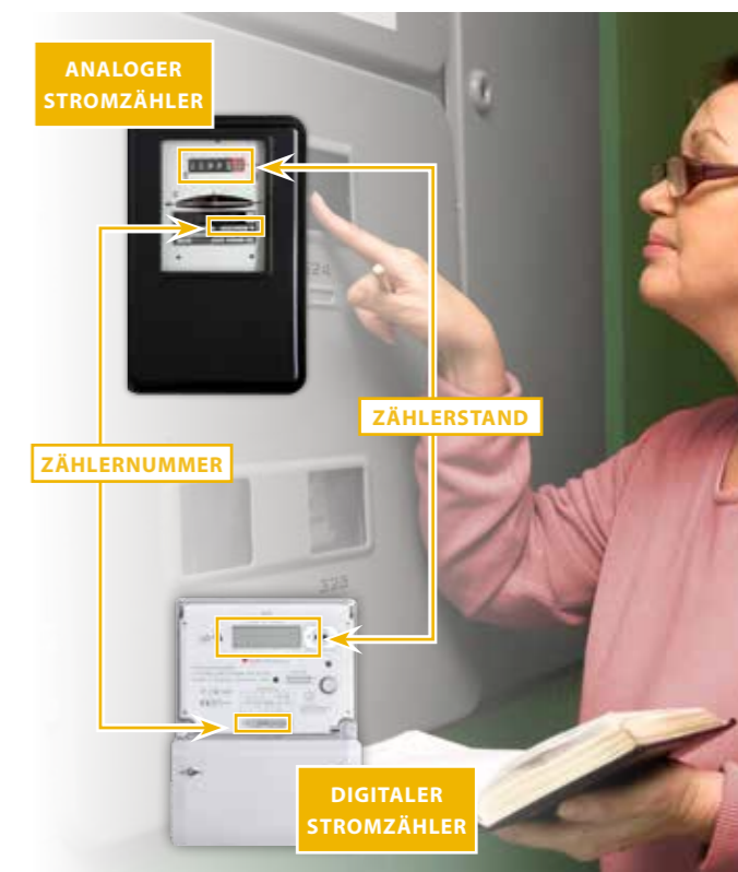
ANALOGER VS. DIGITALER STROMZÄHLER
