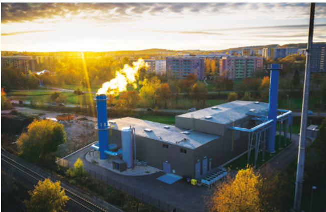
In Gera wird Fernwärme in den ENGIE-Kraftwerken in Lusan (Foto) und Tinz produziert (Foto: Björn Walther).
