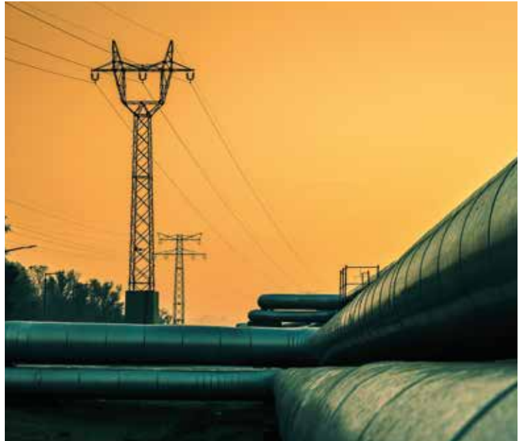
Fernwärmeversorgung der Zukunft: Klimaneutralität bis 2040 ist auch ein Ziel der EGG
