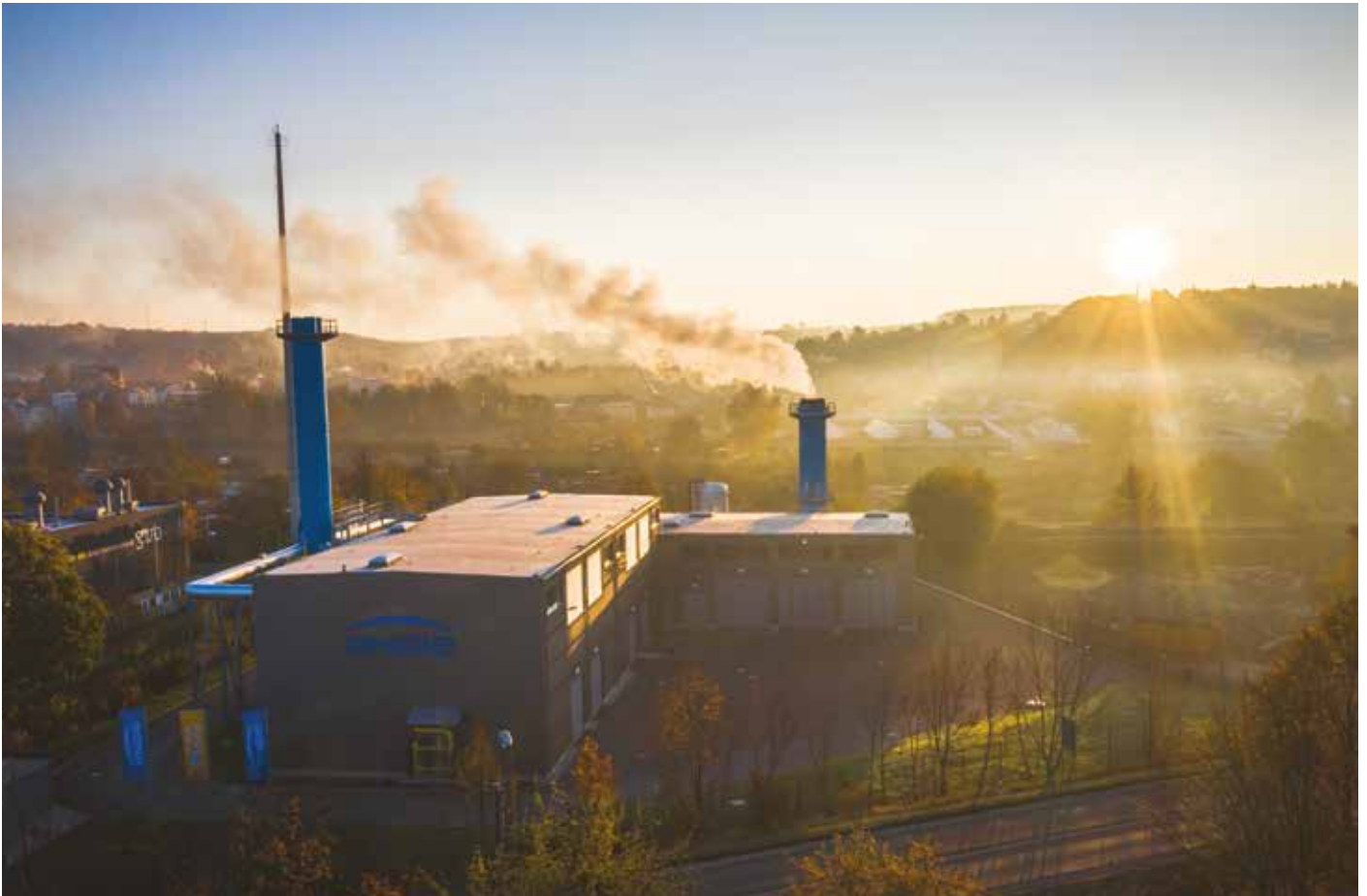
ENGIE-Heizkraftwerk in Gera-Lusan: Die Fernwärme der EGG wird hier und im Heizkraftwerk in Gera-Tinz in umweltfreundlicher Kraft-Wärme-Kopplung erzeugt.
